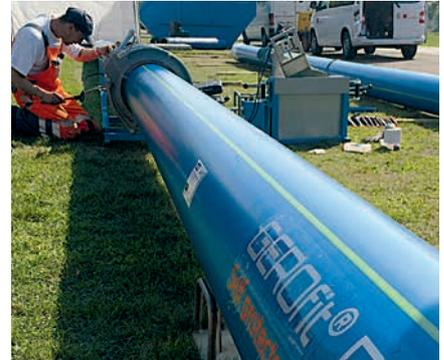
Die Rohre schützen das Trinkwasser zuverlässig vor Kontamination durch aus dem Erdreich diffundierende Schadstoffe.
