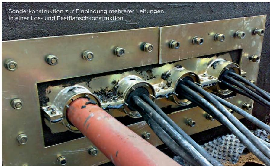
Sonderkonstruktion zur Einbindung mehrerer Leitungen in einer Los- und Festflanschkonstruktion.
