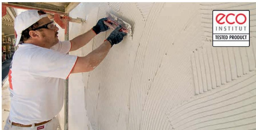
Der Putz lässt sich mit allen üblichen Putzwerkzeugen aufziehen - von Hand oder mit der Putzmaschine.
