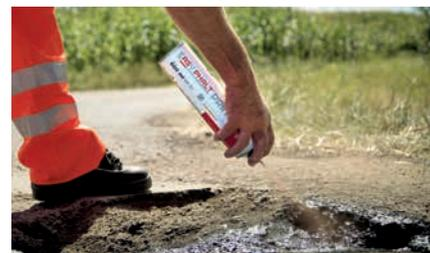
Zuerst die Einbaufläche mit einer bituminösen Grundierung behandeln ...
