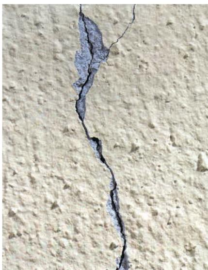
Baumit multiContact MC 55 W eignet sich bestens, um Putzrisse an Fassaden zu sanieren.
