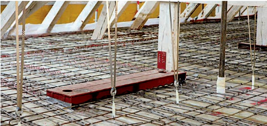
Während des Betoniervorgangs wird die Holzbalkendecke unterstützt.
